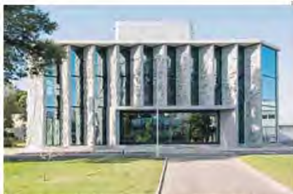
Trabalhos de construção e renovação do edifício K3 do Campus do Lumiar, em Lisboa, tiveram a duração de nove meses
